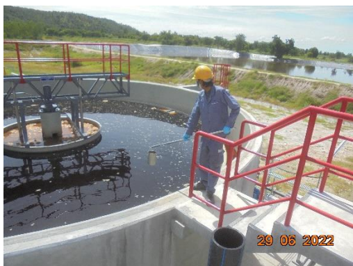
บ่อปรับสภาพสมดุล (Equalization Tank) ของระบบบำบัดน้ำเสียแบบตะกอนเร่ง (AS) ใน (TA2)
